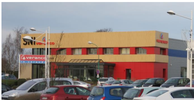
Réfection de façade – Intégration de l'enseigne sur la façade
